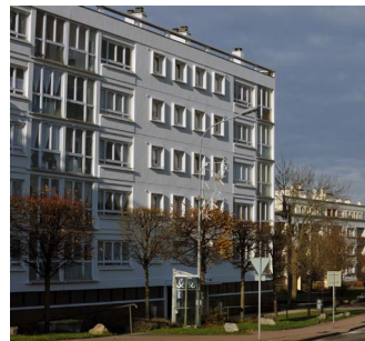
Immeuble boulevard Pierre Guillain
